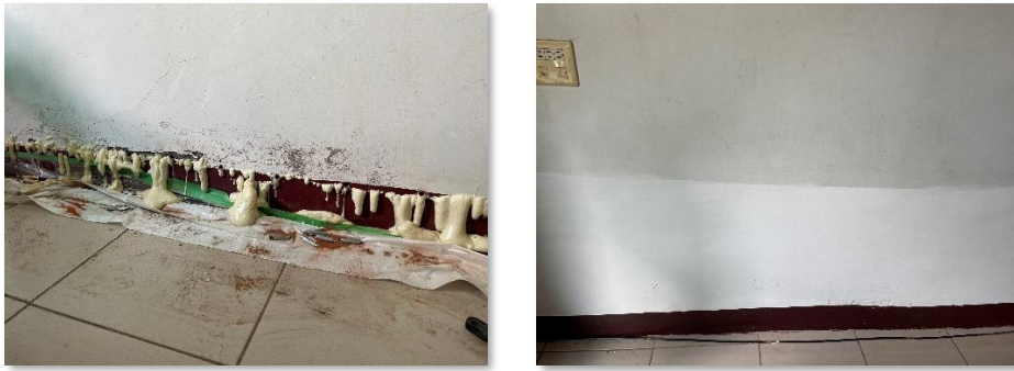
拔除灌注針頭後刮平牆面及復原牆壁油漆
